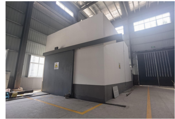
本项目探伤室
